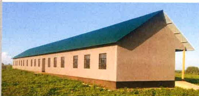
Block mit 5 neuen Klassenräumen an der neuen Primarschule in Emboreet
