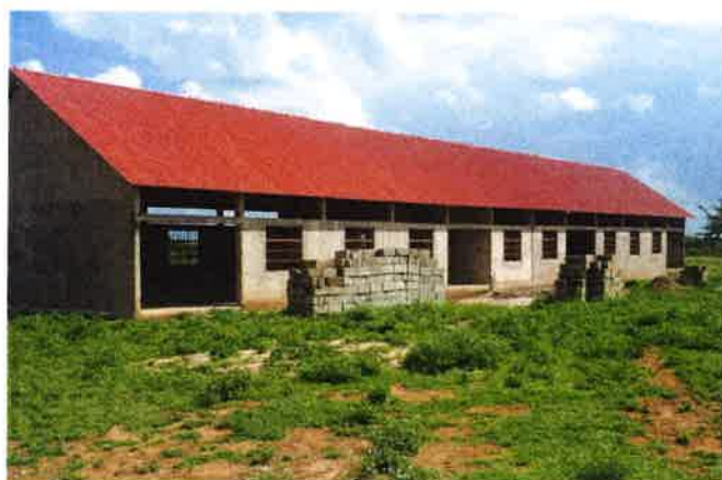
Die beiden Werkstätten am Handwerkerzentrum sind fast fertig
